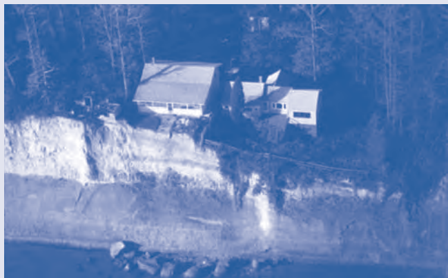
Gambar 10.8 Rumah yang dibangun di tebing
