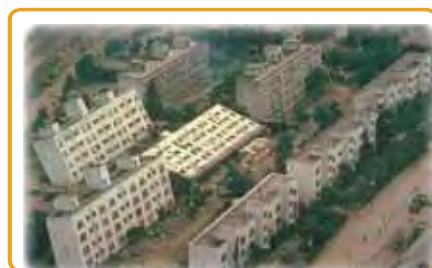
Gambar 1.10 Kerusakan akibat gempa Sumber: img118.images hack.us
