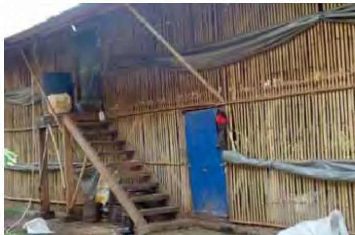
Gambar 9. Dinding kandang bahan dari bambu
