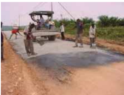
Gambar 1.3 Membangun jalan Sumber: geogrit.wordpress.com
