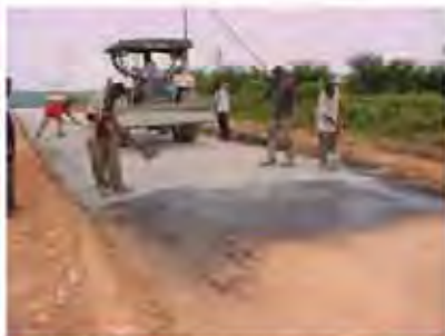
Sumber: geogrit.wordpress.com Gambar 1.5 Membangun jalan
