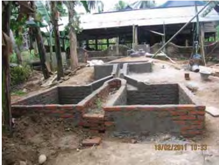
Gambar 153. Contoh slurry pit dari pasangan bata
