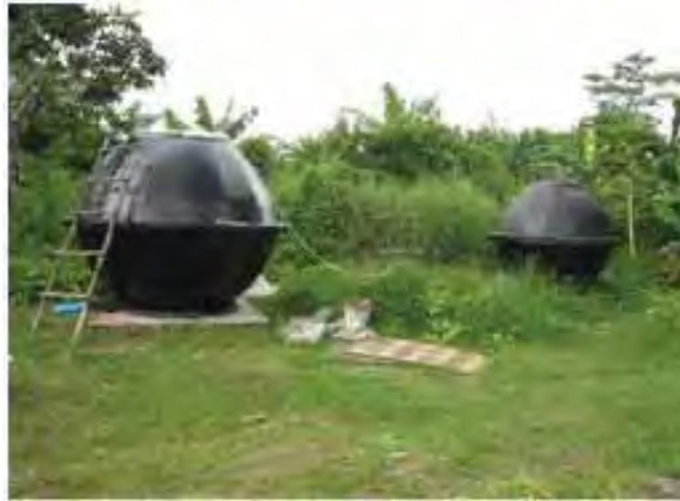
Gambar 30.Reaktor biogas dari bahan fibre glass
