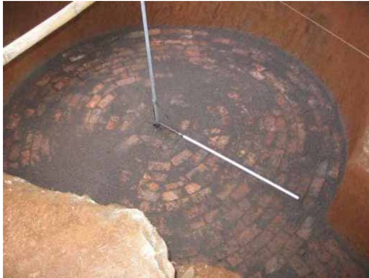
Gambar 49. Pemeriksaan kedataran lantai kerja
