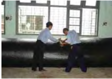
Gambar 36. Menyambung tabung reaktor
