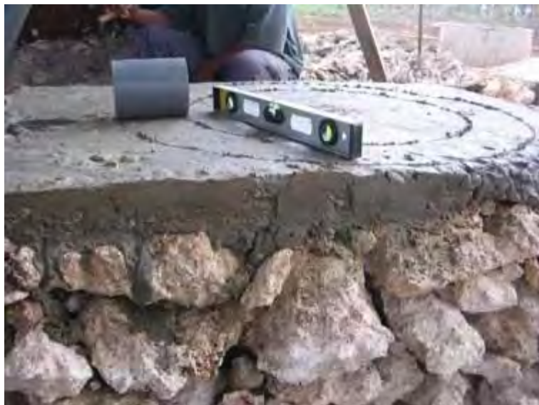
Gambar 135. Menggambar lay out inlet
