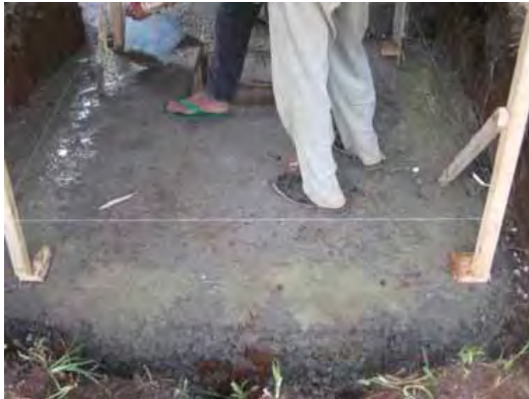
Gambar 116. Pemasangan profil pasangan pada lantai Outlet
