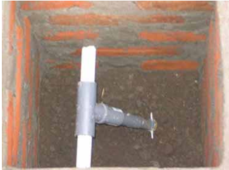
Gambar 146. Water drain harus dipasang dengan posisi miring
