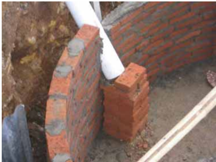
Gambar 64. Penyesuaian ketinggian pipa Inlet dari pondasi
