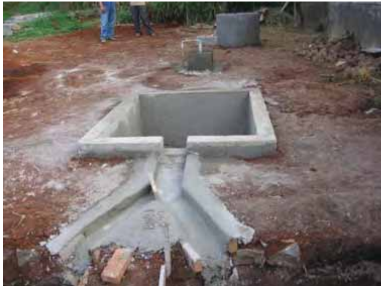
Gambar 121. Outlet yang telah selesai dibangun
