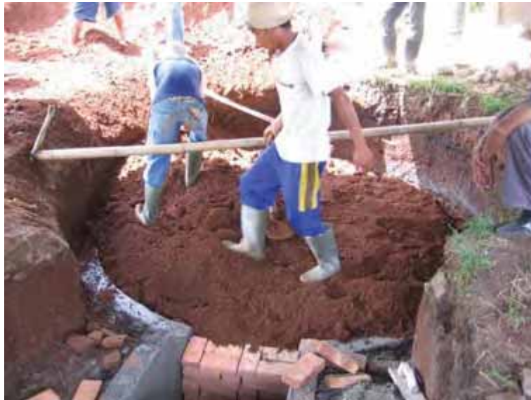
Gambar 83. Pemadatan tanah lapis demi lapis
