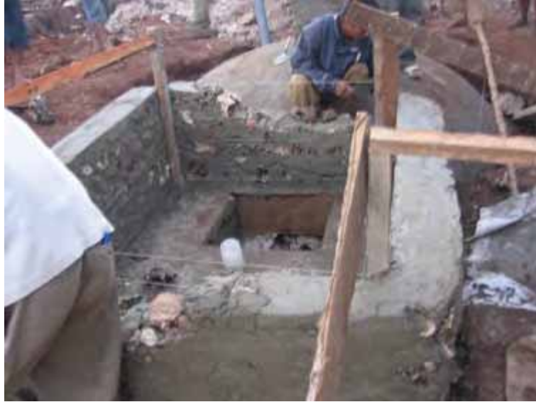
Gambar 122. Outlet dari pasangan batu kali
