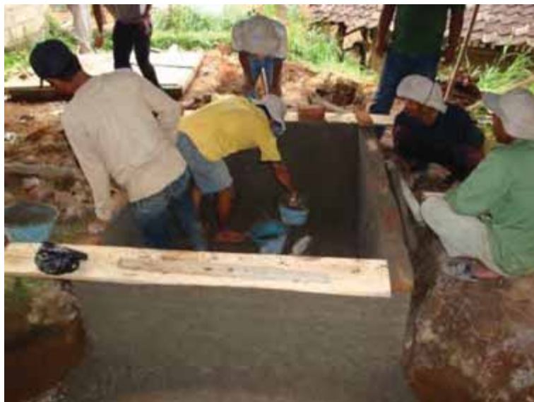
Gambar 119. Pekerjaan pemlesteran dinding Outlet
