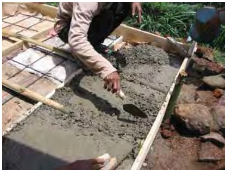
Gambar 102. Pengecoran plat penutup Outlet
