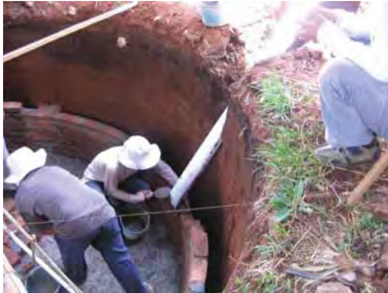
Gambar 65. Pemasangan pipainlet
