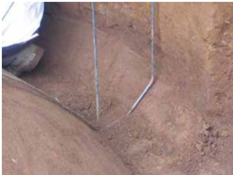
Gambar 86. Pembentukan tepi kubah dengan mal
