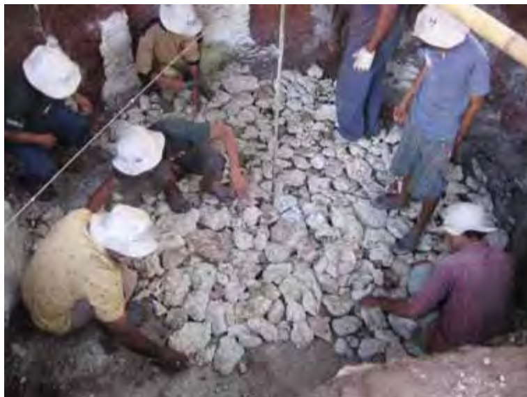
Gambar 50. Lantai kerja yang menggunakan batu kali
