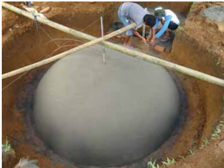
Gambar 88. Cetakan kubah setelah dilapisi pasir
