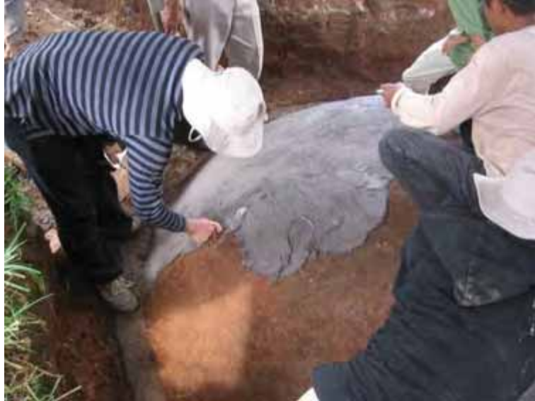
Gambar 87. Melapisi kubah dengan pasir basah setebal \pm 1 cm
