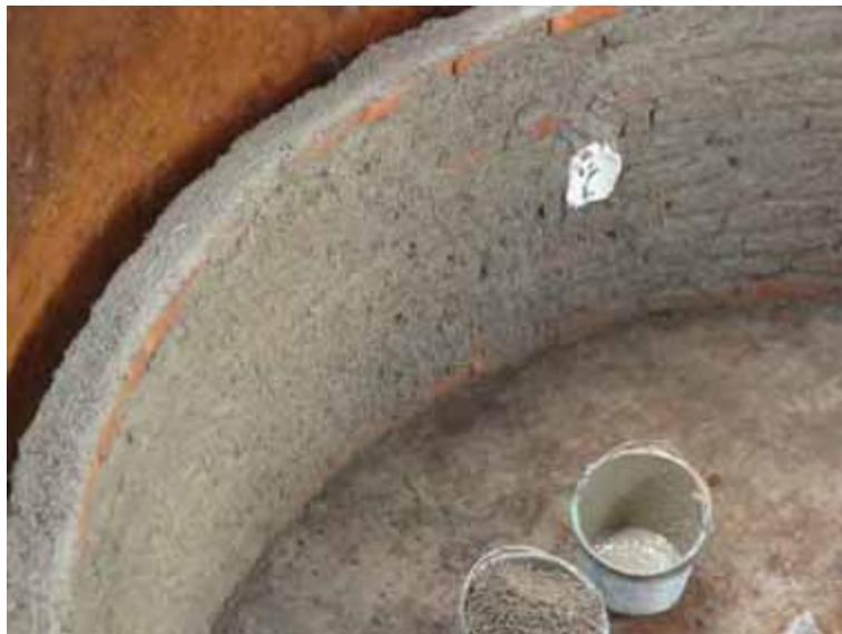
Gambar 66. Pengkamprotan dinding tangki pencerna
