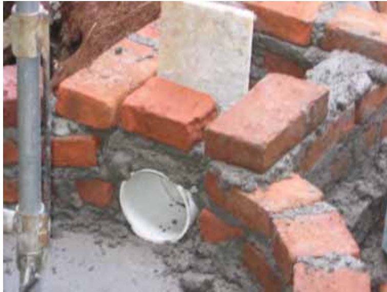
Gambar 130. Memasang kotak pada mulut pipa inlet
