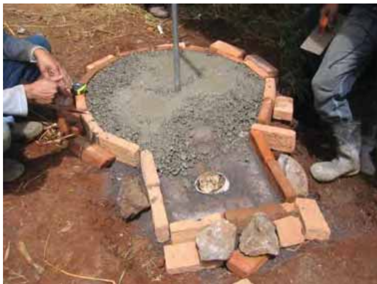
Gambar 127. Mengecor lantai dasar inlet
