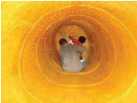
Gambar 35. Melubangi penutup tangki pencerna
