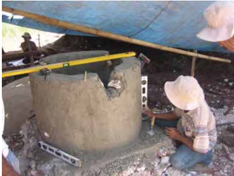
Gambar 138. Melakukan finishing inlet sebelum pemasangan mixer
