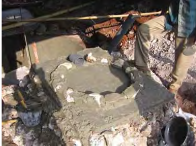
Gambar 136. Memasang batu kali dan pipa saluran
