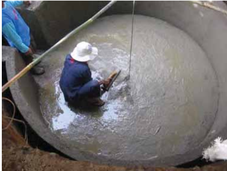
Gambar 71. Pekerjaan finishing lantai pondasi
