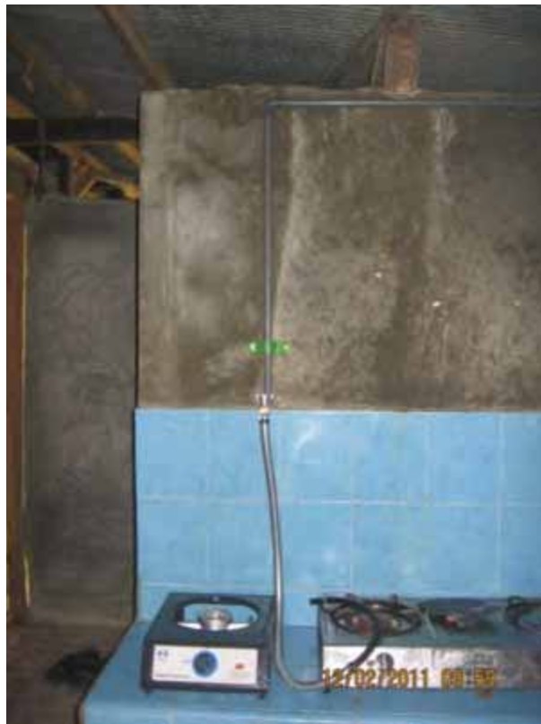
Gambar 165. Contoh instalasi manometer dan kompor
