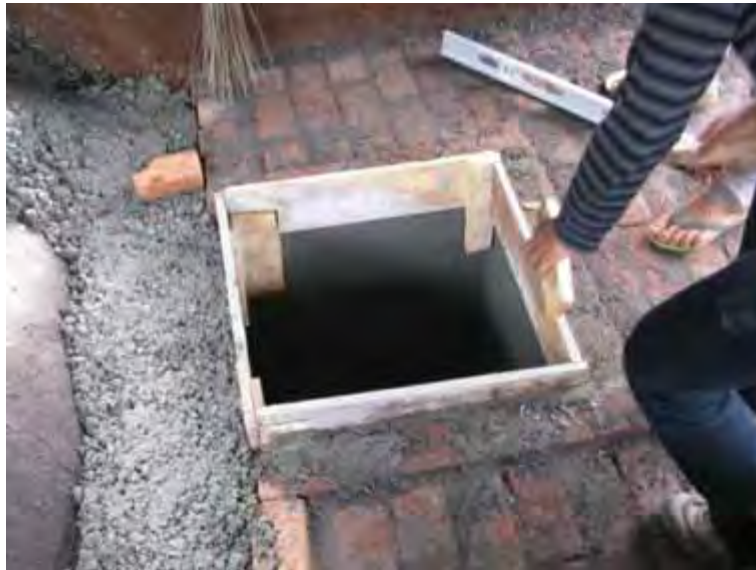
Gambar 114. Memasang bekisting untuk manhole
