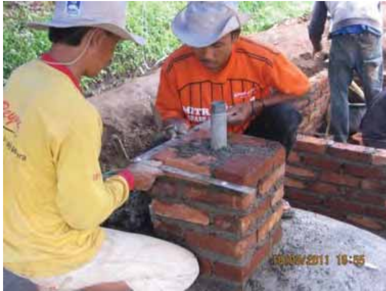
Gambar 107. Pemeriksaan kesikuan pasangan bata
