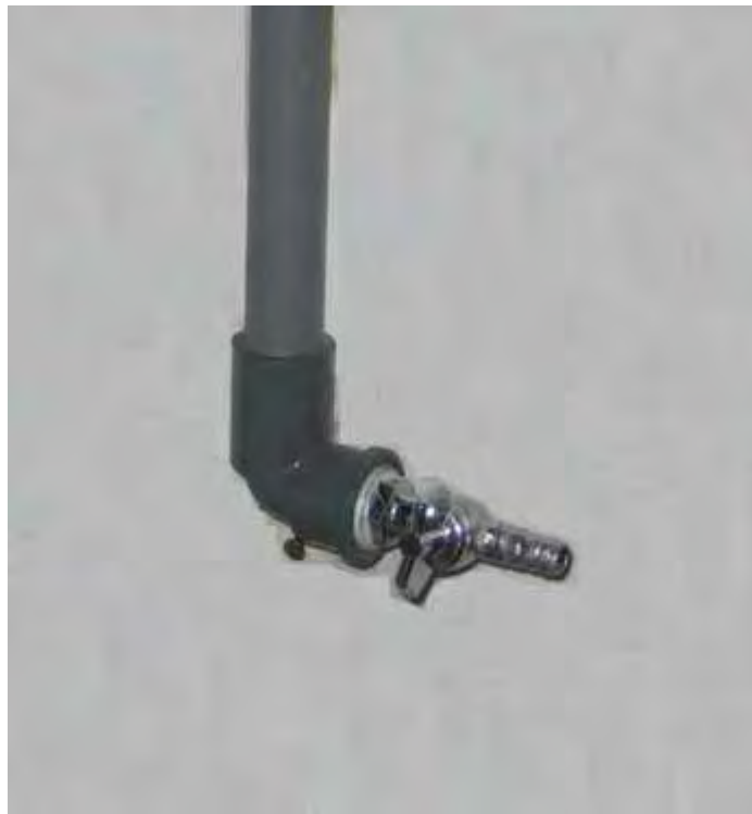
Gambar 163. Pemasangan kran gas
