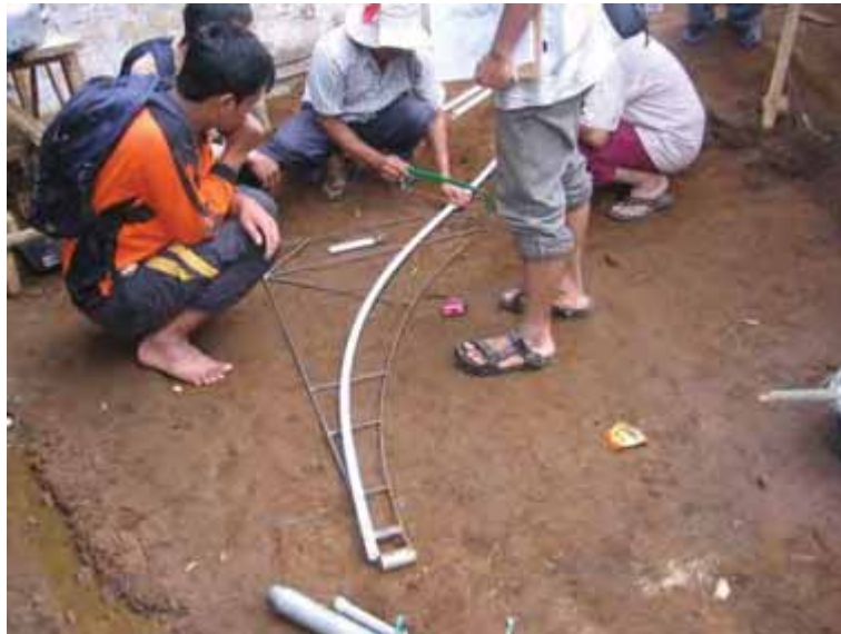
Gambar 89. Menyiapkan mal besi sebagai acuan pengecoran
