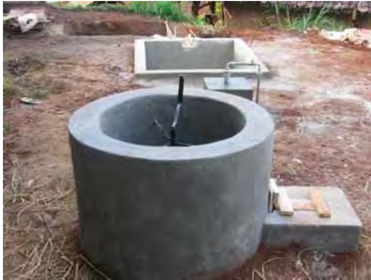
Gambar 134. Inlet yang telah siap digunakan
