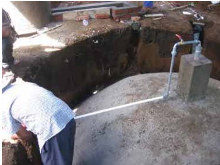
Gambar 143. Pemasangan pipa PVC yang menuju ke dapur
