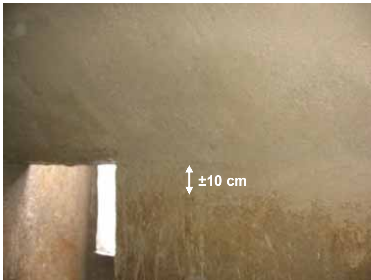
Gambar 172. Finishing lapisan ke 1
