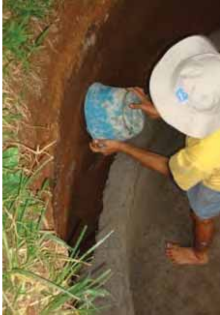
Gambar 69. Pengisian celah dinding tanah dengan tangki pencerna
