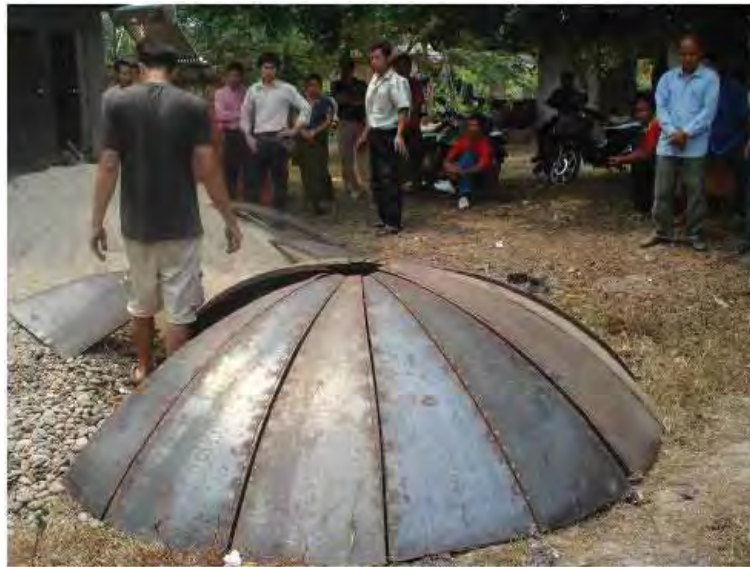
Gambar 79. Contoh cetakan kubah dari plat besi (1)
