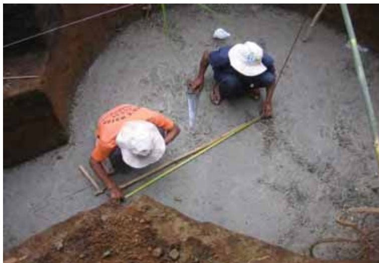
Gambar 54. Menggambar lay out digester pada pondasi
