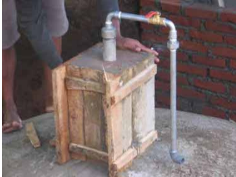
Gambar 142. Pemasangan pipa penyambung
