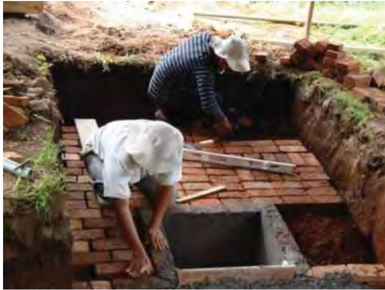
Gambar 112. Menyusun bata untuk lantai kerja
