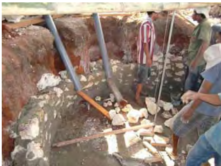
Gambar 78. Pemasangan pipa Inlet
