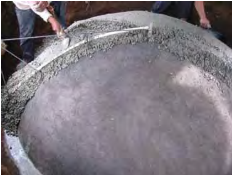
Gambar 92. Pengecoran beton bagian demi bagian
