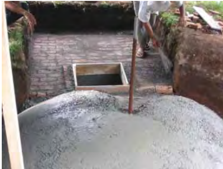
Gambar 93. Menyiapkan tempat pipa gas utama
