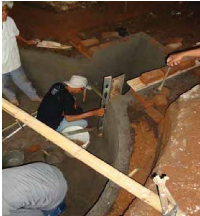
Gambar 70. Pemeriksaan dinding tangki pencerna
