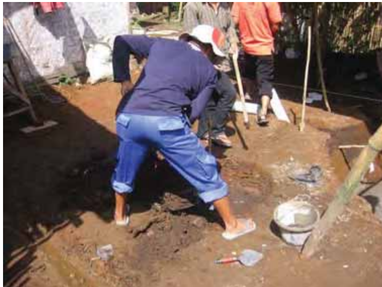
Gambar 125. Menggali tanah untuk menyesuaikan dasar inlet
