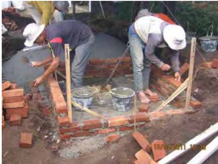
Gambar 118. Pekerjaan pasangan bata dinding Outlet
