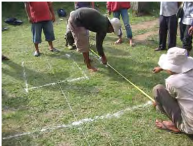
Gambar 190. Mengukur dan menandai outlet
