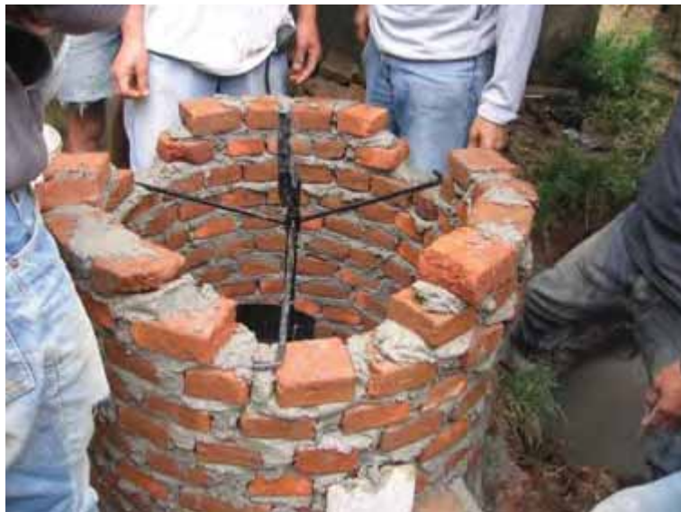
Gambar 131. Setting out mixer pada inlet
