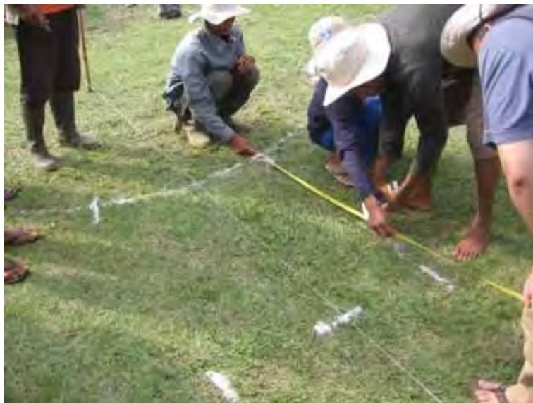
Gambar 188. Mengukur dimensi manhole
