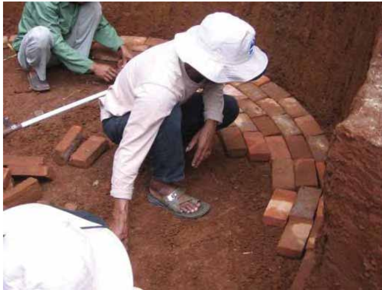
Gambar 47. Menyusun bata untuk lantai kerja
