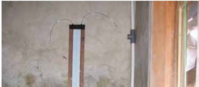
Gambar 159. Pemasangan fitting T sebelum ujung akhir pipa
