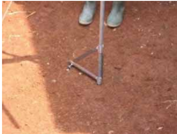
Gambar 45. Pemasangan mal pada tiang as
