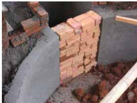
Gambar 82. Pasangan bata pada Manhole
