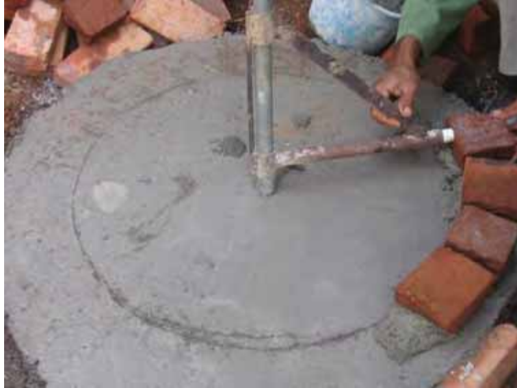
Gambar 128. Menggambar lay out inlet di atas pondasi
