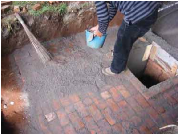
Gambar 113. Penghamparan pasir untuk mengisi celah antara bata
