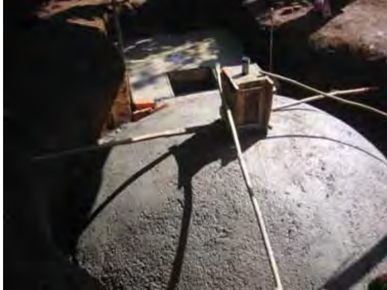
Gambar 111. Turret setelah selesai dicor
