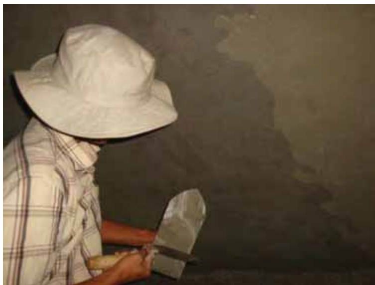
Gambar 174. Gunakan sendok dan roskam untuk plesteran
