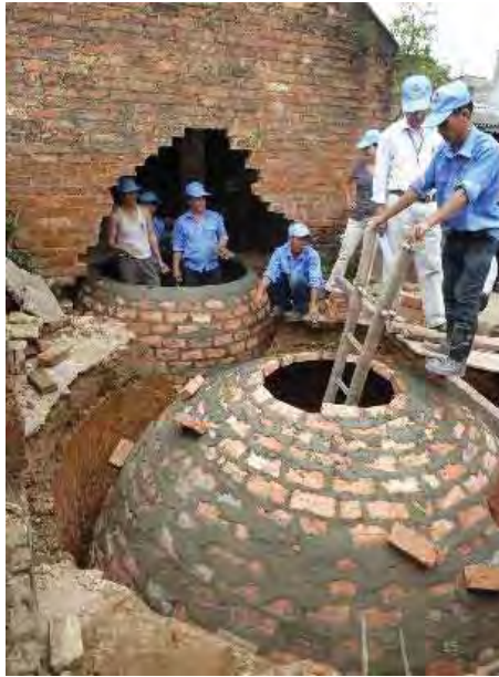
Gambar 22. Pembangunan reaktor biogas (Vietnam)
