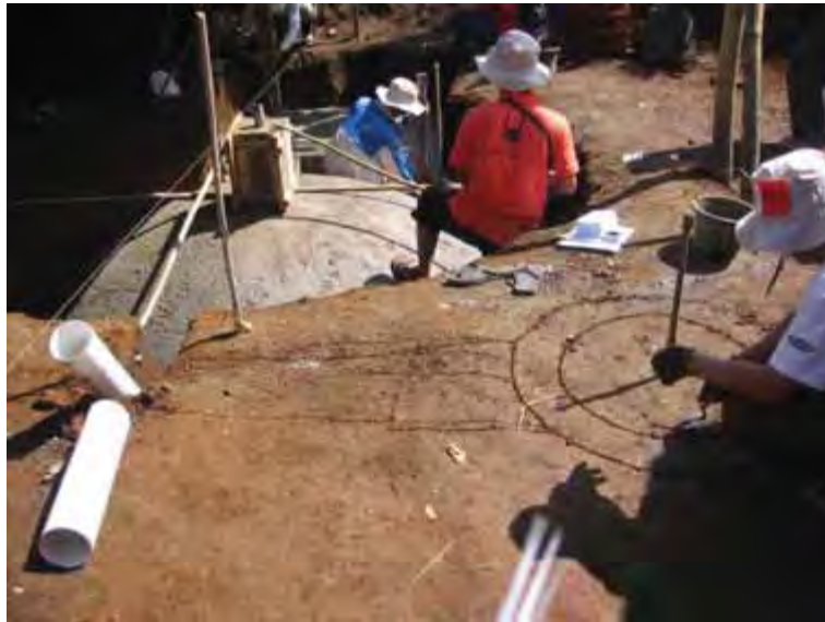
Gambar 124. Menggambar lay out inlet di atas tanah
