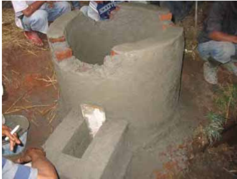
Gambar 132. Pekerjaan finishing inlet
