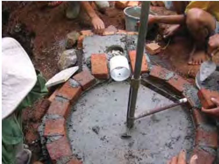
Gambar 129. Memasang bata dan pipa saluran
