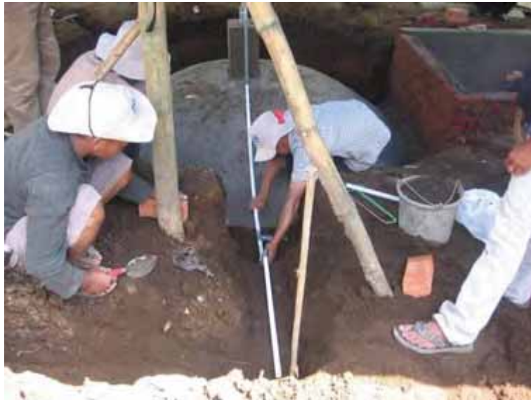
Gambar 144. Penggalan tanah untuk kotak water drain
