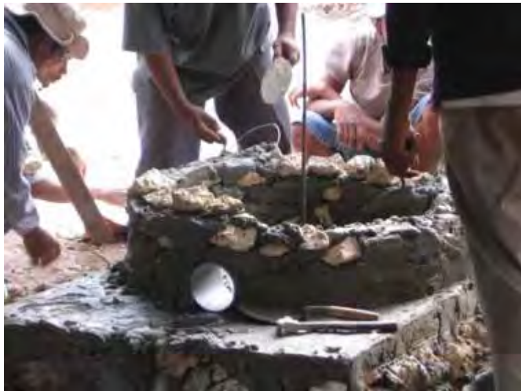
Gambar 137. Memasang dinding inlet
