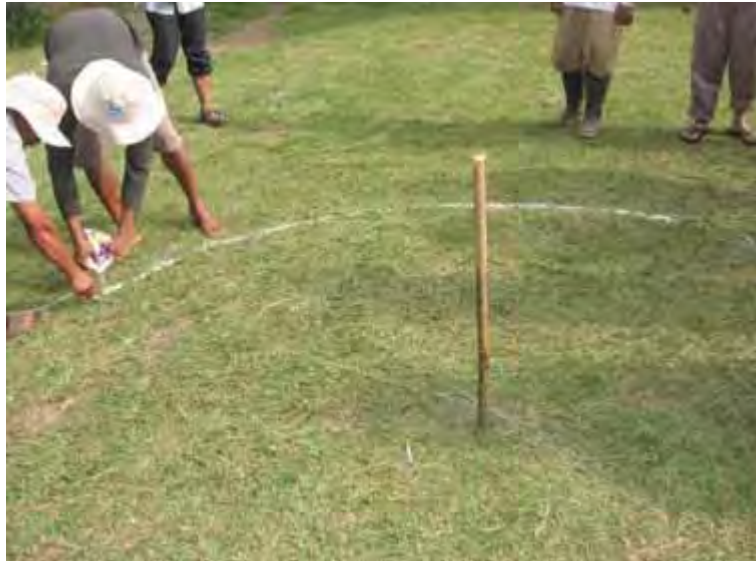
Gambar 187. Membuat garis diameter tangki pencerna
