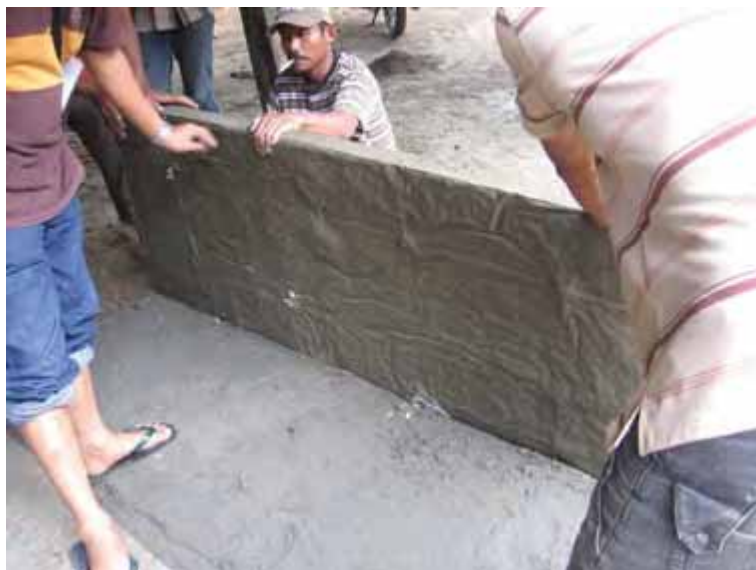
Gambar 105. Pemeriksaan bagian bawah plat penutup Outlet
