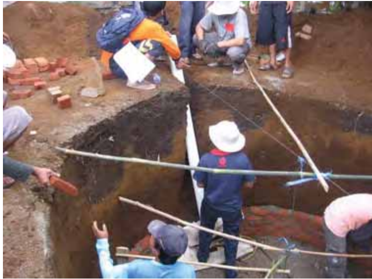
Gambar 63. Penyetelan pipa Inlet
