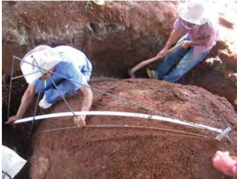
Gambar 85. Pembentukan cetakan kubah dengan mal
