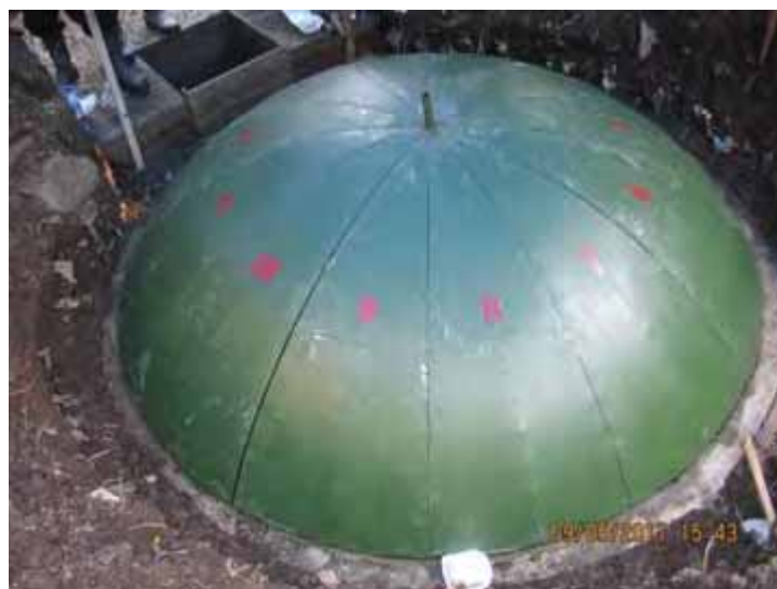
Gambar 80. Contoh cetakan kubah dari plat besi (2)
