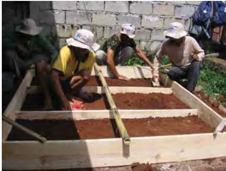
Gambar 99. Memasang bekisting plat penutup Outlet
