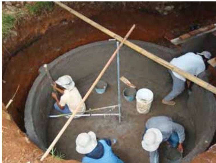
Gambar 68. Pekerjaan pemlesteran tangki pencerna
