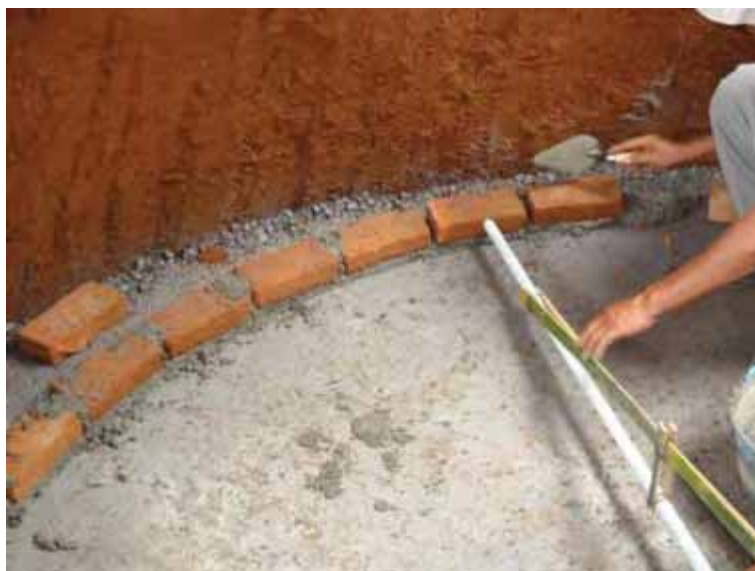
Gambar 60. Memasang bata tangki pencerna Perhatikan bahwa mal harus tepat ditengah-tengah batu bata.
