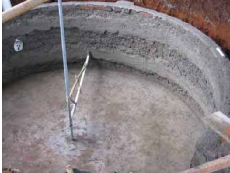
Gambar 67. Pembuatan jalur untuk kepala plesteran
