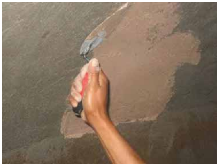
Gambar 177. Gunakan sendok spesi untuk lapisan ke 5
