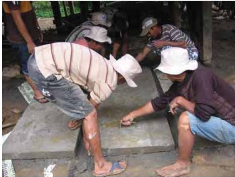
Gambar 104. Proses pengangkatan plat penutup Outlet
