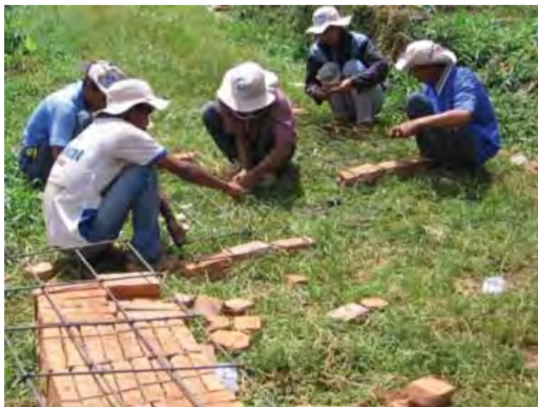
Gambar 100. Pemotongan besi tulangan plat penutup Outlet
