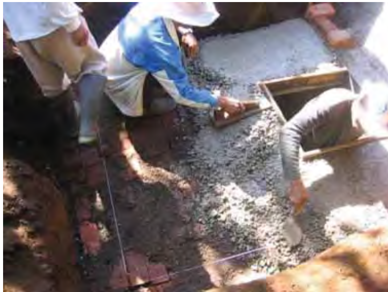
Gambar 115. Pengecoran lantai Outlet
