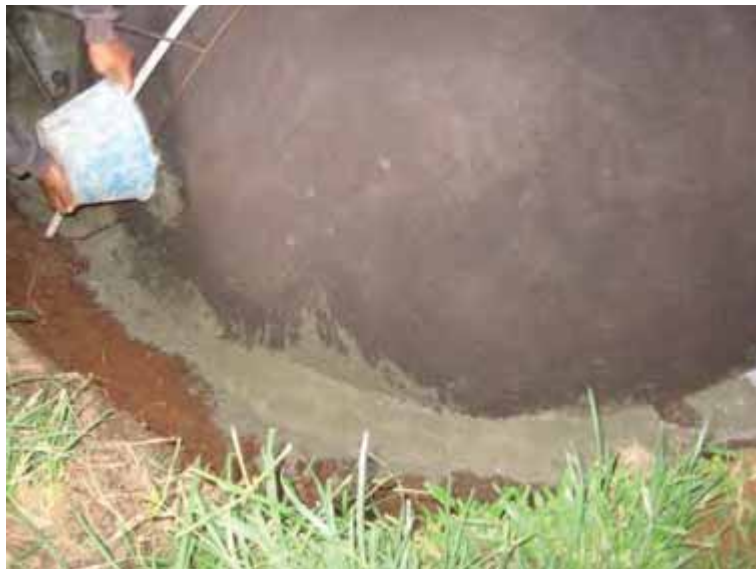
Gambar 90. Mencurahkan adukan dimulai dari bawah cetakan
