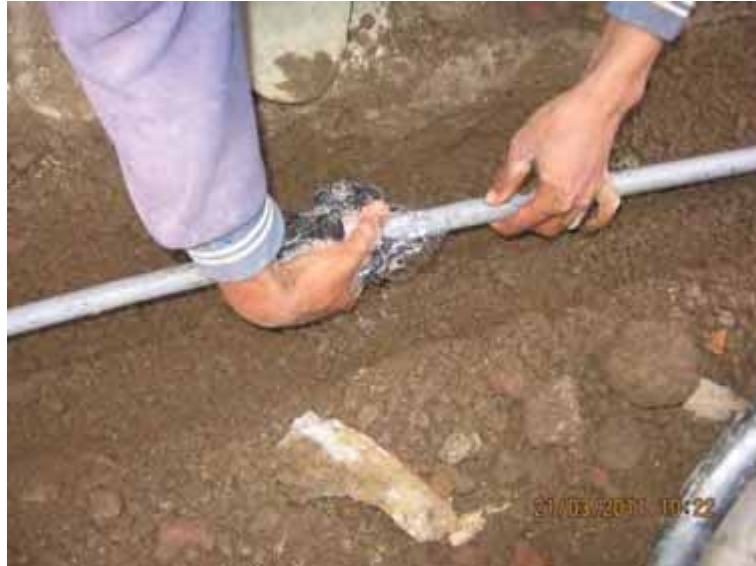
Gambar 166. Cara memeriksa kebocoran pipa pada sambungan
