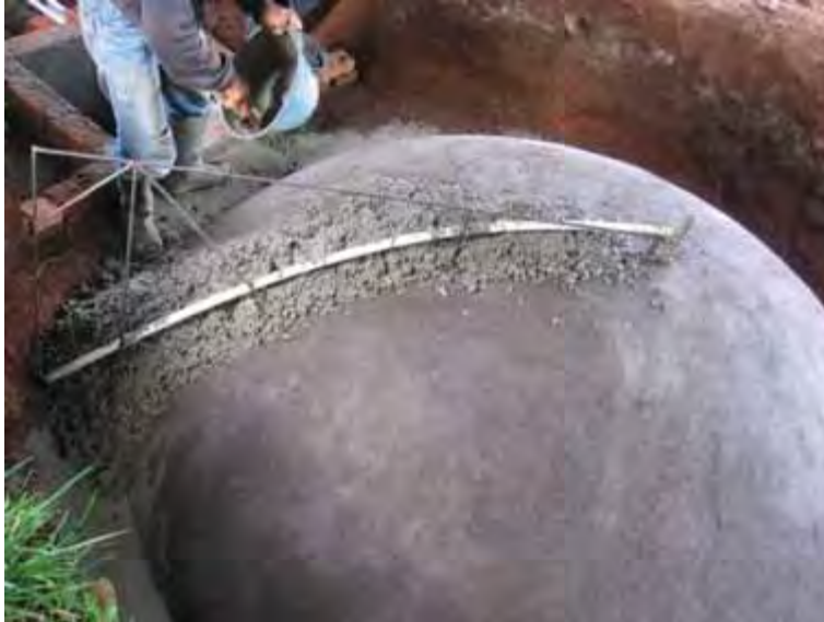
Gambar 91. Mencurahkan adukan beton di bagian atas kubah
