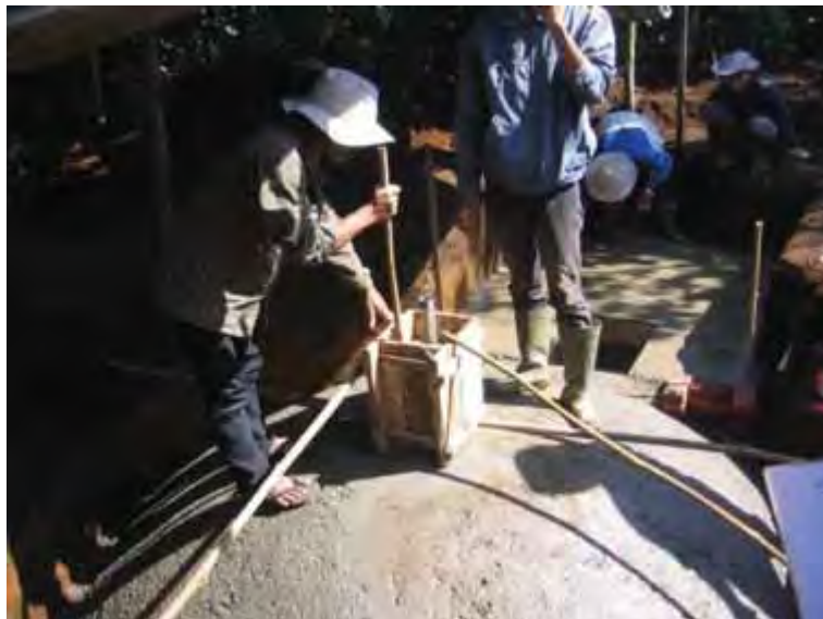
Gambar 110. Pemasangan bekisting turet dari beton
