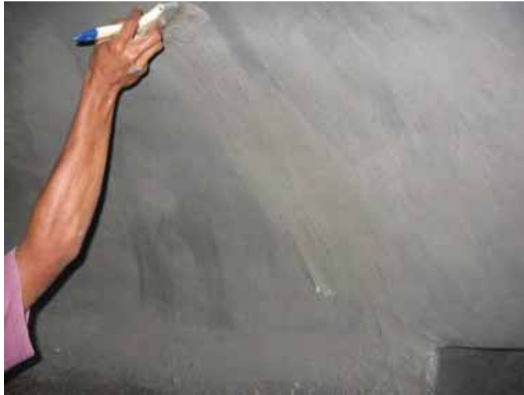
Gambar 178. Gunakan kuas untuk lapisan ke 6
