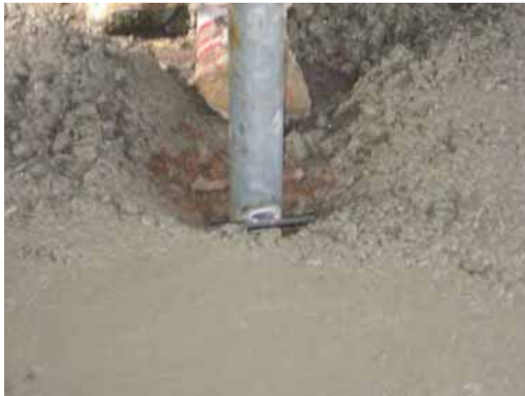
Gambar 94. Pemasangan pipa gas utama
