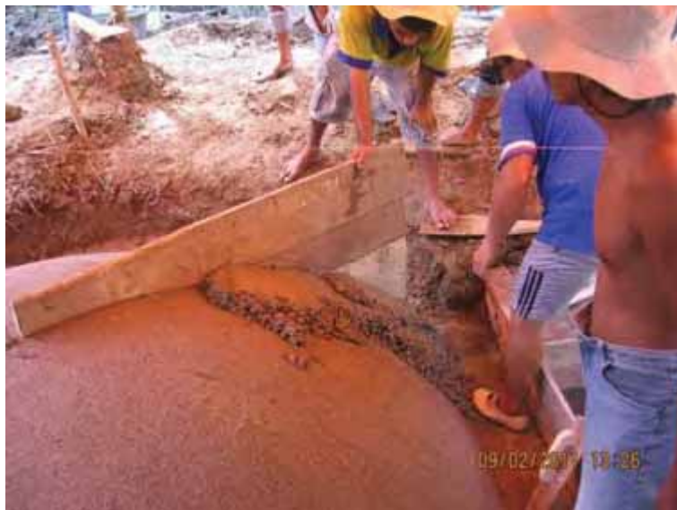
Gambar 98. Penggunaan mal kayu sebagai cetakan beton (2)
