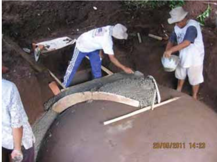
Gambar 97. Penggunaan mal kayu sebagai cetakan beton (1)
