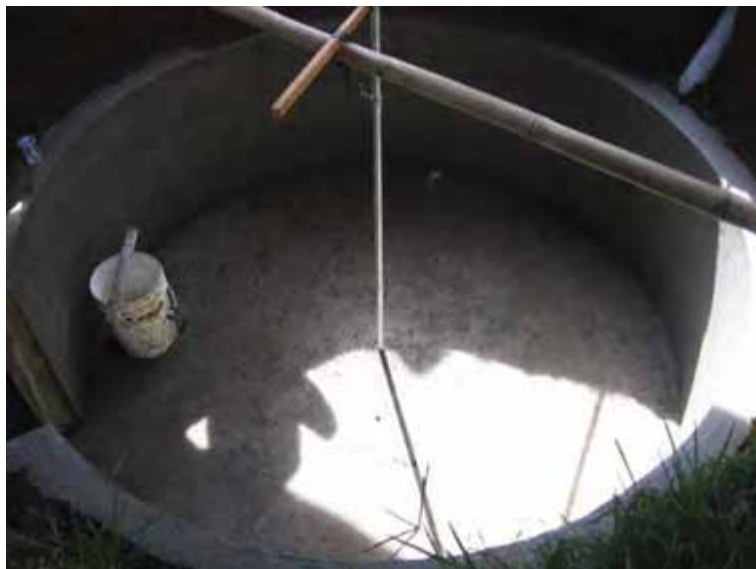
Gambar 72. Tangki pencernaan yang telah selesai dikerjakan
