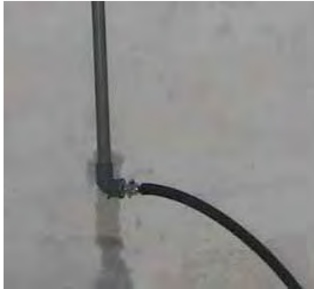
Gambar 164. Menghubungkan kran gas dengan kompor
