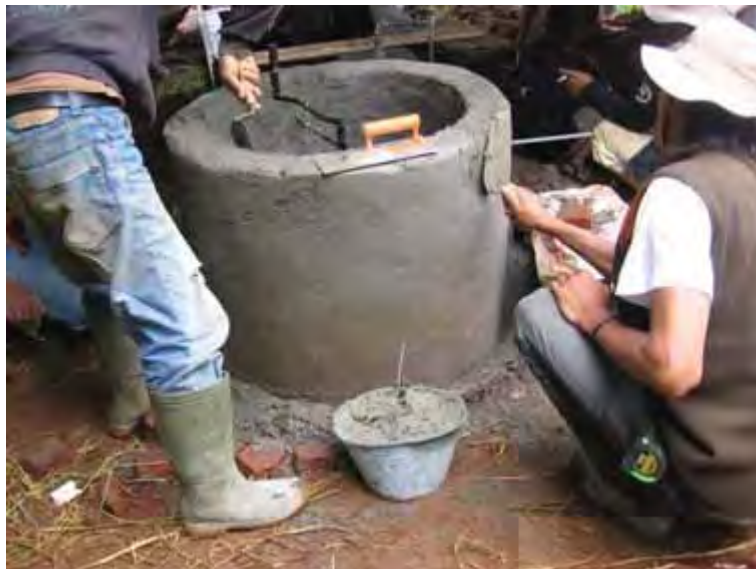
Gambar 133. Pemasangan mixer dan finishing kembali inlet
