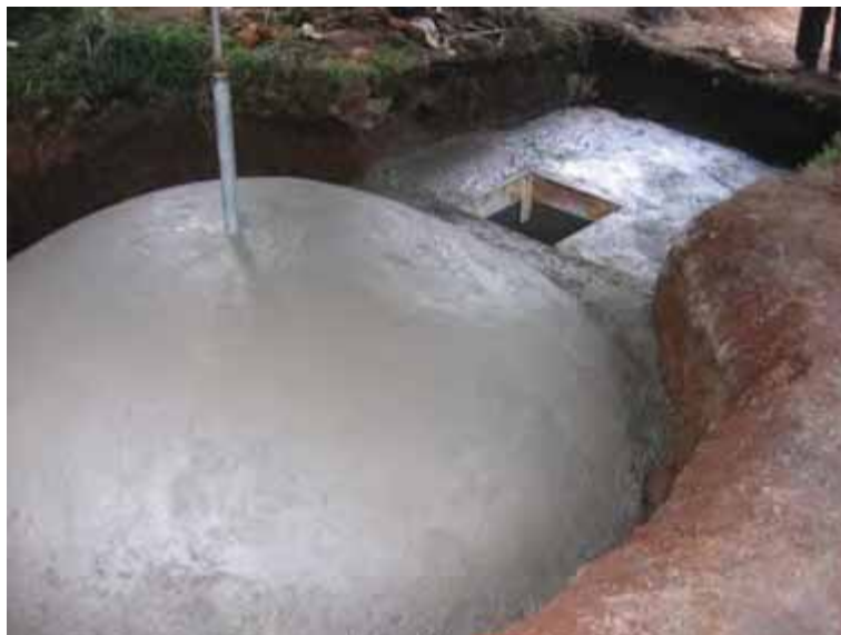
Gambar 96. Permukaan kubah setelah dirapikan
