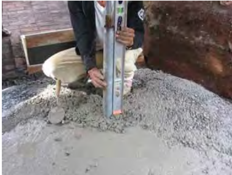
Gambar 95. Pipa gas utama harus dipasang setegak mungkin
