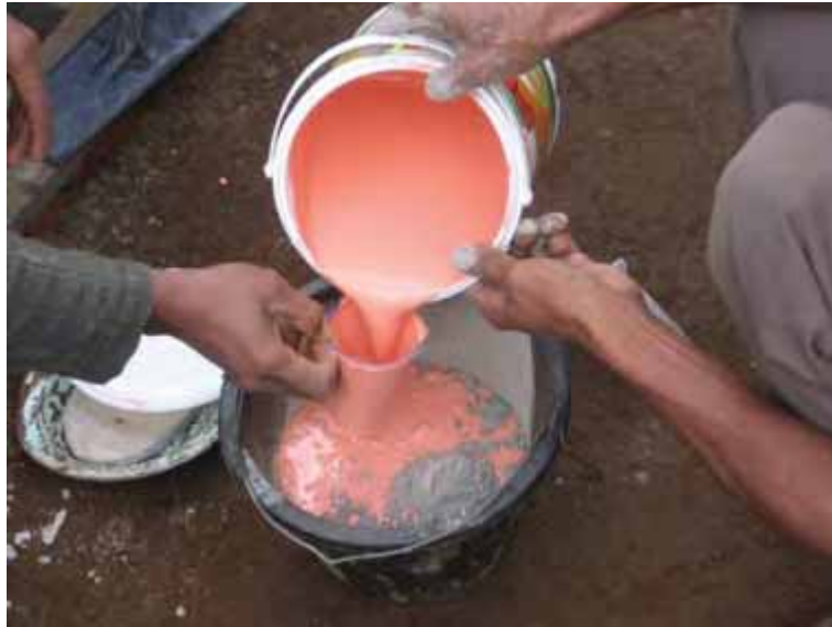
Gambar 176. Pencampuran semen dan cat acrylic
