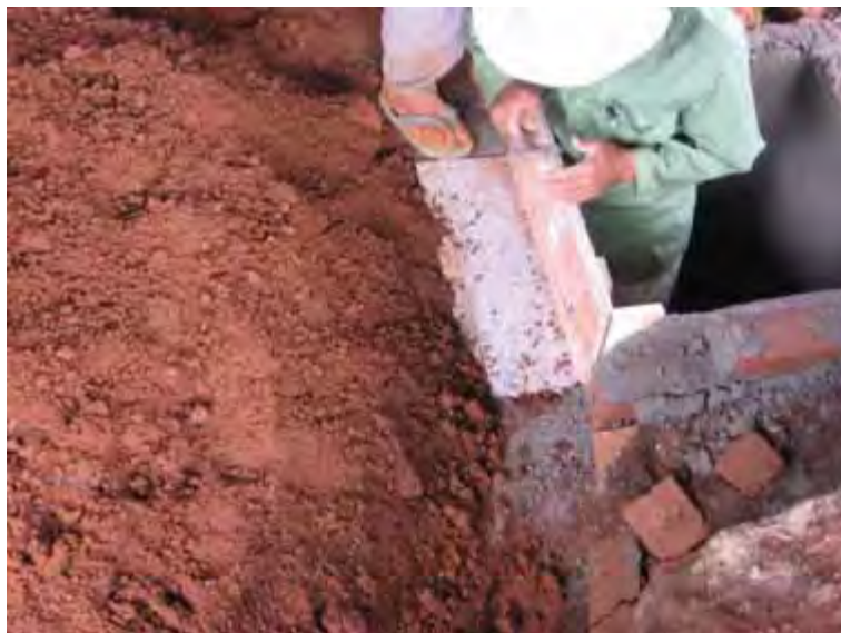
Gambar 84. Pemasangan bekisting untuk balok kubah
