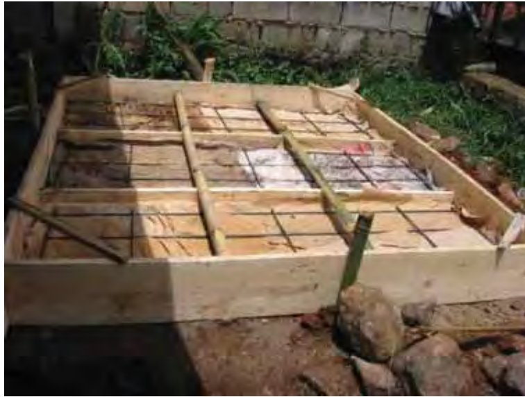
Gambar 101. Memasang besi tulangan plat penutup Outlet
