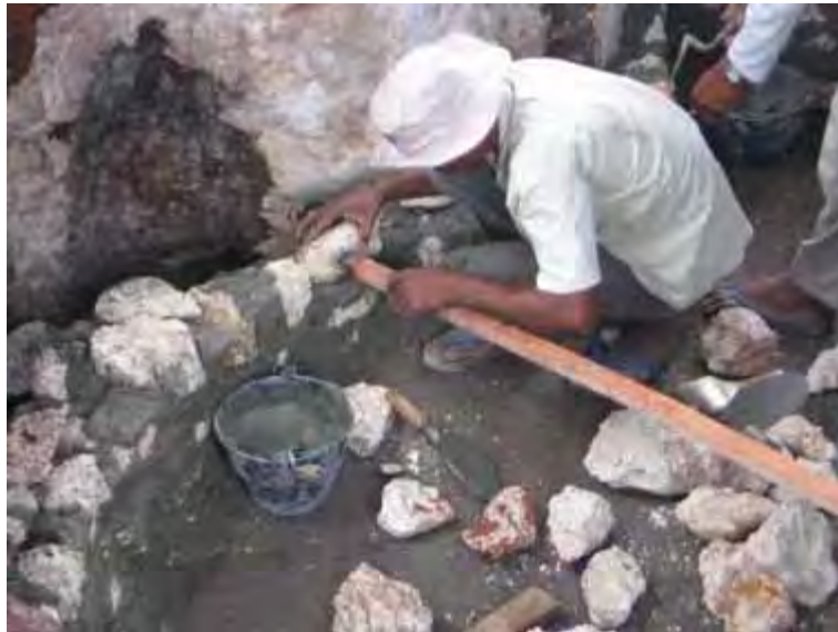
Gambar 77. Dinding tangki pencerna dari pasangan batu kali
