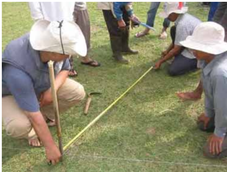
Gambar 186. Mengukur diameter tangki pencerna
