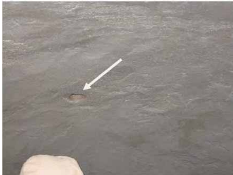
Gambar 179. Finishing lubang untuk pipa gas utama harus rapi
