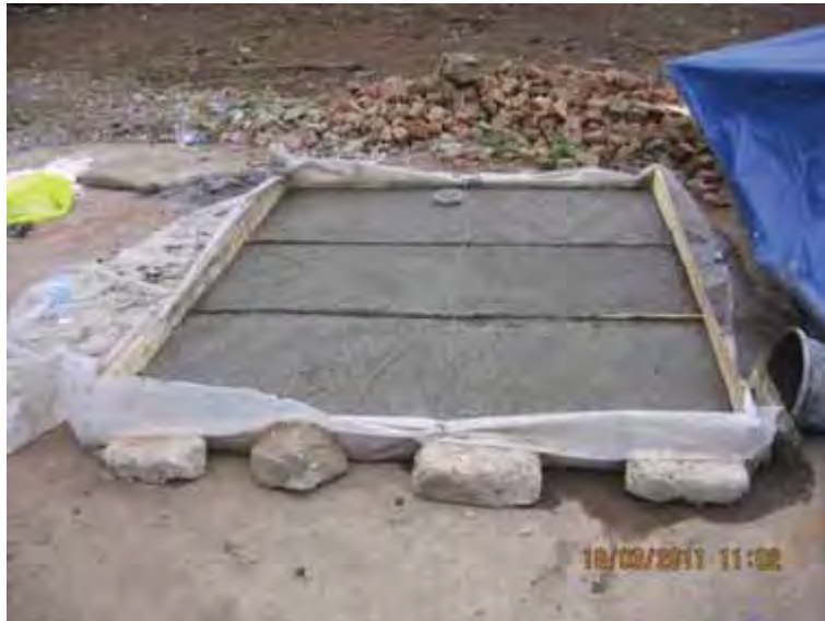
Gambar 103. Plat penutup Outlet setelah selesai dicor
