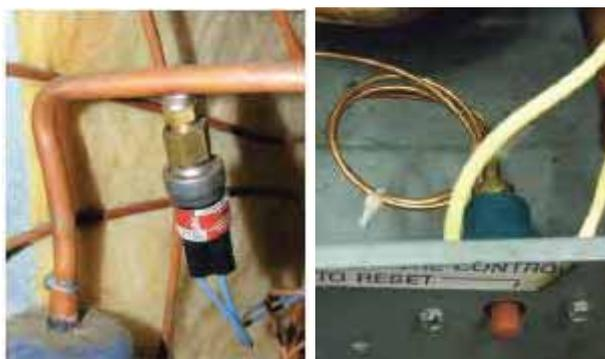
Gambar 5.14 Low-pressure Switch pada Unit Tata Udara Domestik
