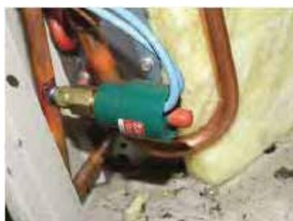
Gambar 5.15 High-pressure Switch pada Unit Tata Udara Domestik
