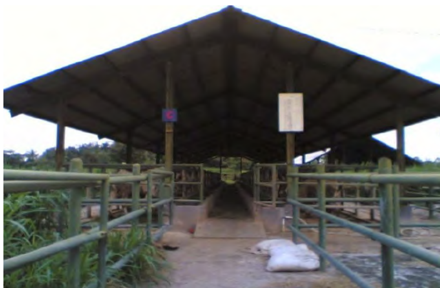
Gambar 4. Kandang sapi yang mempunyai atap tipe A dengan dinding berupa pipa – pipa besi
